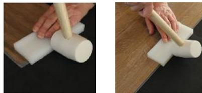
Die Elemente der letzten Reihe werden zugeschnitten und passgenau mit 10 mm Abstand zur Wand eingesetzt.
